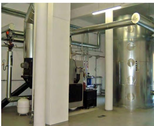
Der Schlosskomplex mit Kindergarten und Grundschule im Ortsteil Gebelzig wurde mit Öl beheizt. Nach der Sanierung wird das Schloss über ein Nahwärmenetz auf der Grundlage von Holzhackschnitzeln versorgt, unterstützt von einer Sonnenkollektoranlage auf dem Dach des ehemaligen Speichers. Außerdem sind eine Bankfiliale, ein Einkaufsmarkt und verschiedene Eigenheime an die Wärmetrasse angeschlossen. Die Ölheizung ist weiterhin als Spitzenlastkessel vorhanden.
